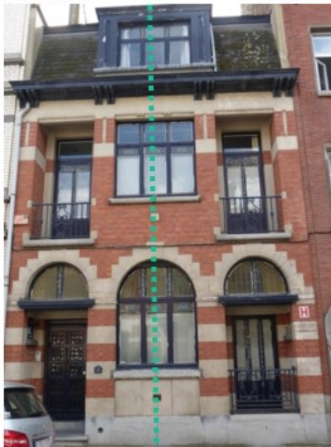
Bakstenen met simili (beploistering ter imitatie van natuursteen). Het materiaal dat gebruikt wordt, is nog traditioneel.
