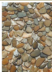
béton de galets lavés
