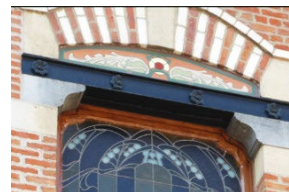
linteau en acier apparent
