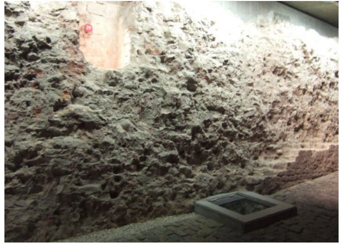
Afvoerpijp van en doorkijk op een beerput ©EGK
