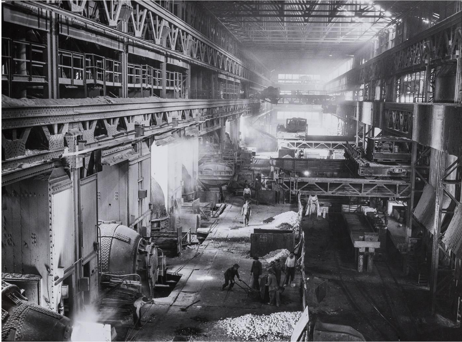
Fabriek met metalen steunen en balken
