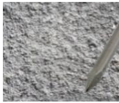
Afwerking met puntijzer
