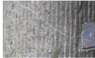
Afwerking met puntijzer
