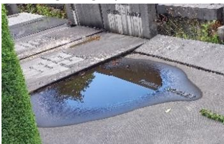
Door de golving blijft het water staan
