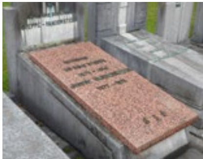
De granieten plaat, die met cement aan de soufflet uit blauwe hardsteen is bevestigd, is losgekomen en van de helling afgegleden.
