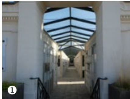
Het glasraam van de hoofd galerij was al enkele jaren verdwenen. Omdat er geen spoor meer van te vinden was, heeft het restauratiebureau gekozen voor een modern glasraam.
