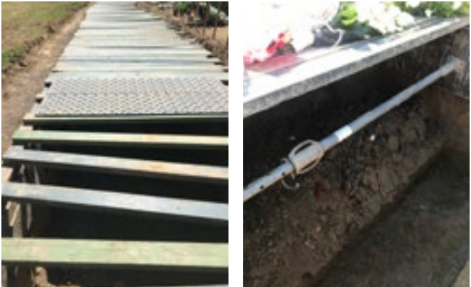
Opeenvolging van gestutte kuilen in de gewone lijn voor grondbegravingen - Begraafplaats van Anderlecht
