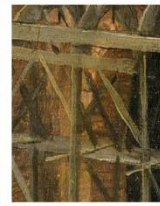
EEN STELLING MET BALKEN EN PLANKEN
