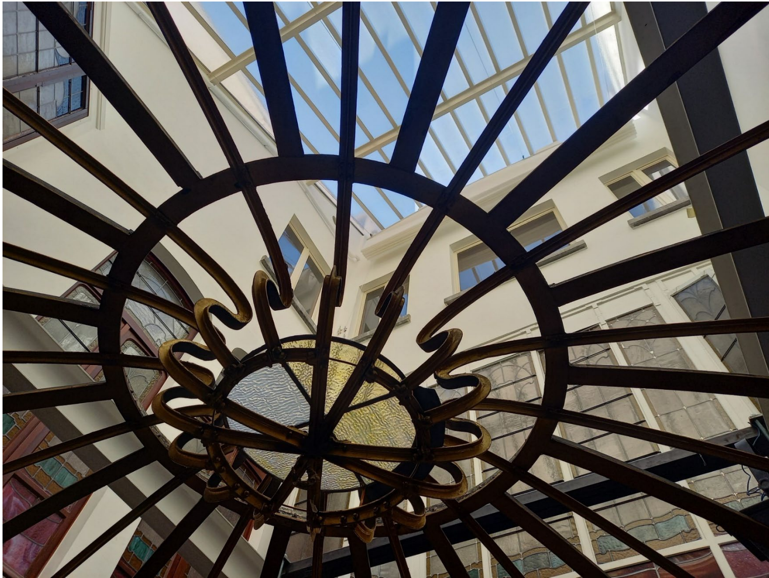
Structure de la verrière du jardin d'hiver dépouillée de ses vitraux lors de la campagne de restauration de 2023
