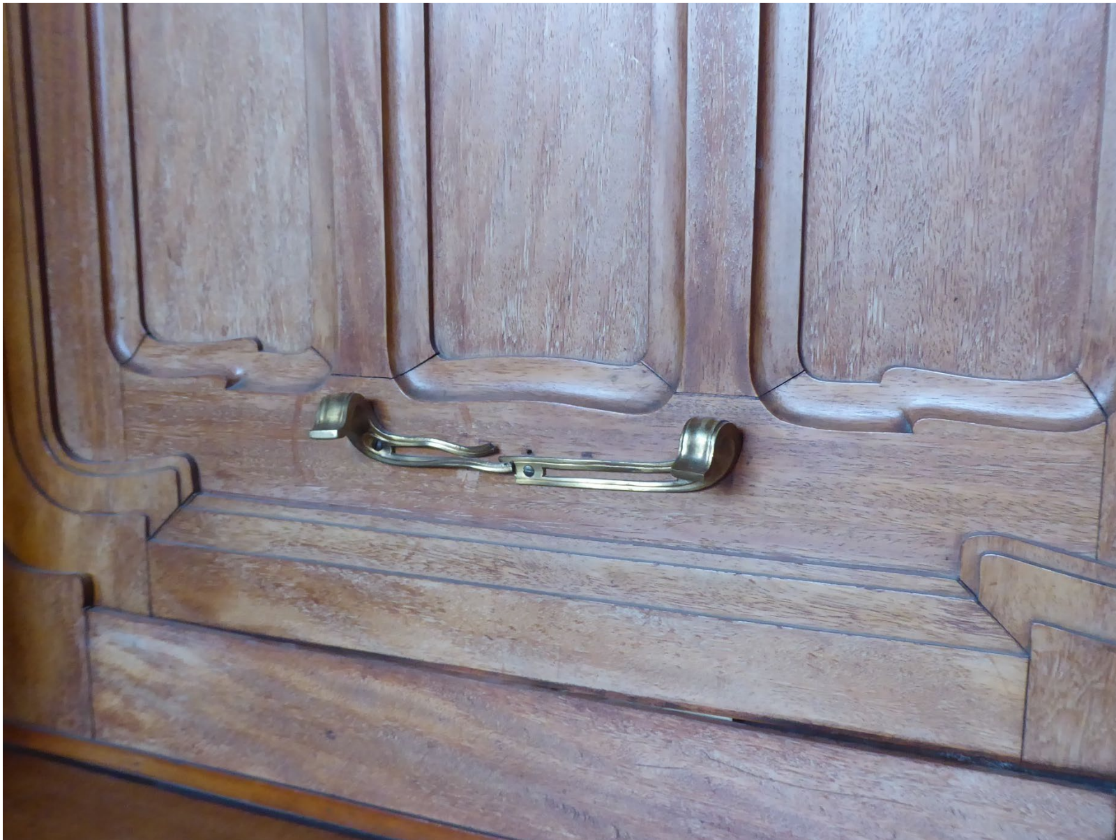
Détail du monte-plat
