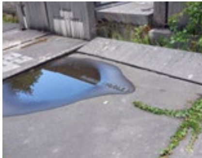
Het grafteken is ontworpen zonder rekening te houden met goede afwatering. Het water stagneert en zal de steen eroderen.
