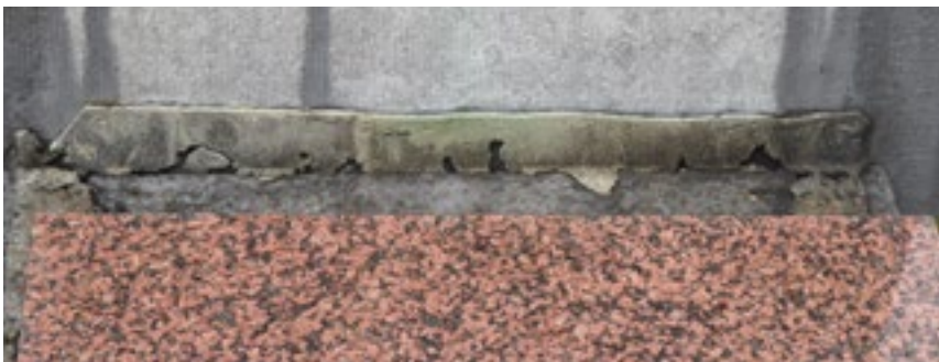
De granieten plaat, die met cement aan de soufflet uit blauwe hardsteen is bevestigd, is losgekomen en van de helling afgegleden.
