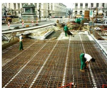
Les rails de tram se sont effondrés et il a fallu les réparer. Et le béton, c'est plus moderne que les voûtes anciennes : c'est solide et pratique !
