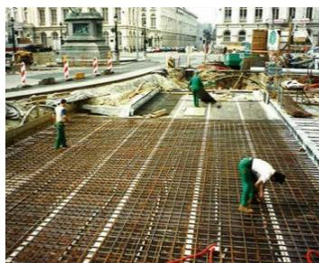
Pour redécouvrir les vestiges de cette partie du palais, il a fallu creuser le sol de la place Royale. Ensuite on les a protégés avec une dalle de béton armé.
