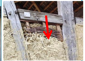
leem (mengeling van stro en modder)
