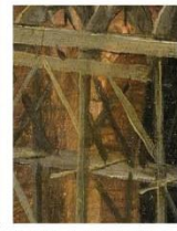
EEN STELLING MET BALKEN EN PLANKEN
