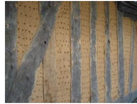
vakwerk (houten structuur)
